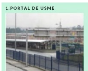
Figura 10: fotografía portal de usme. (Diagnóstico de Usme,2019).
