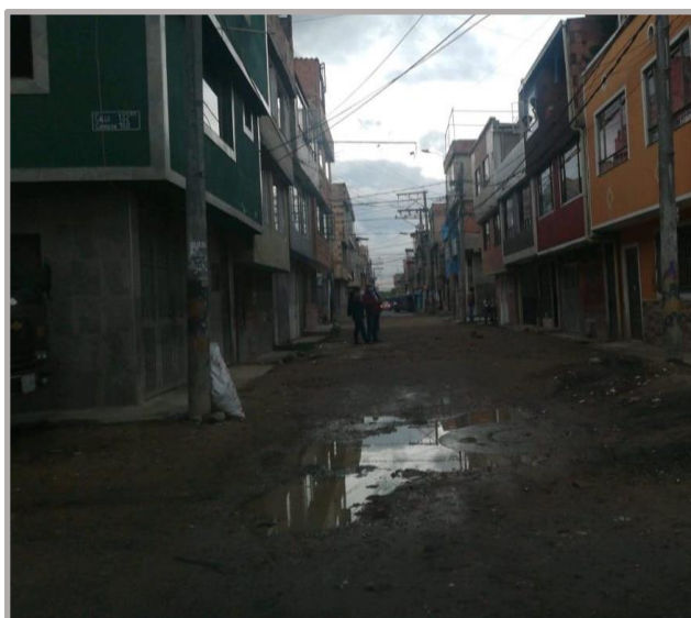
Ilustración 20. Estado actual de la calle 131 B # 159 en el Barrio Santa Cecilia
