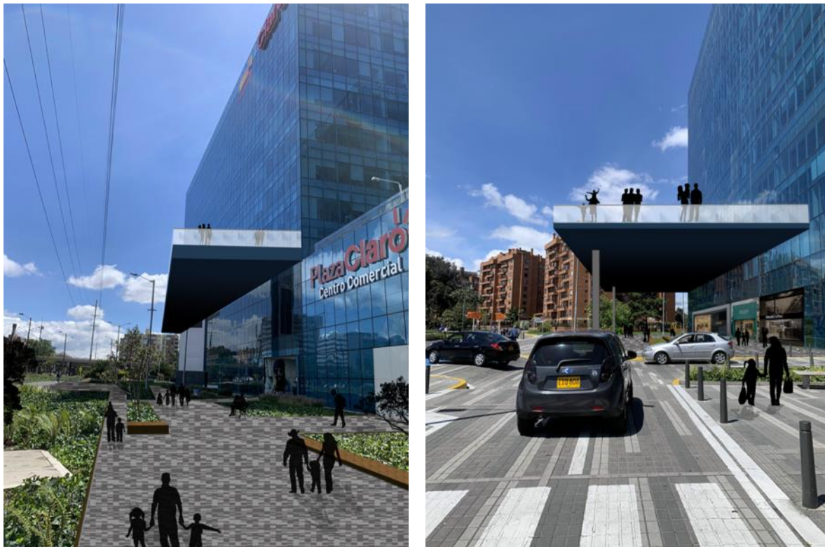
Figura 30 Vista real de la aplicación de los lineamientos en plaza claro
