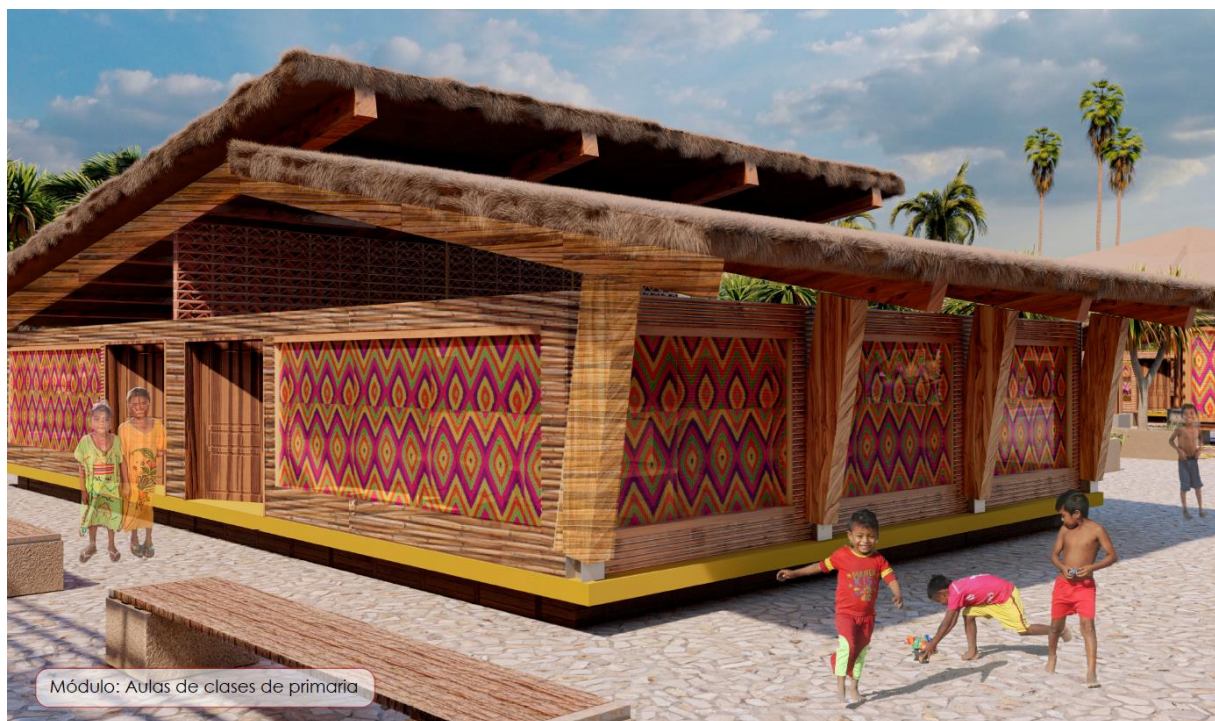
Figura 22. Módulo de aulas de clases de primaria.
