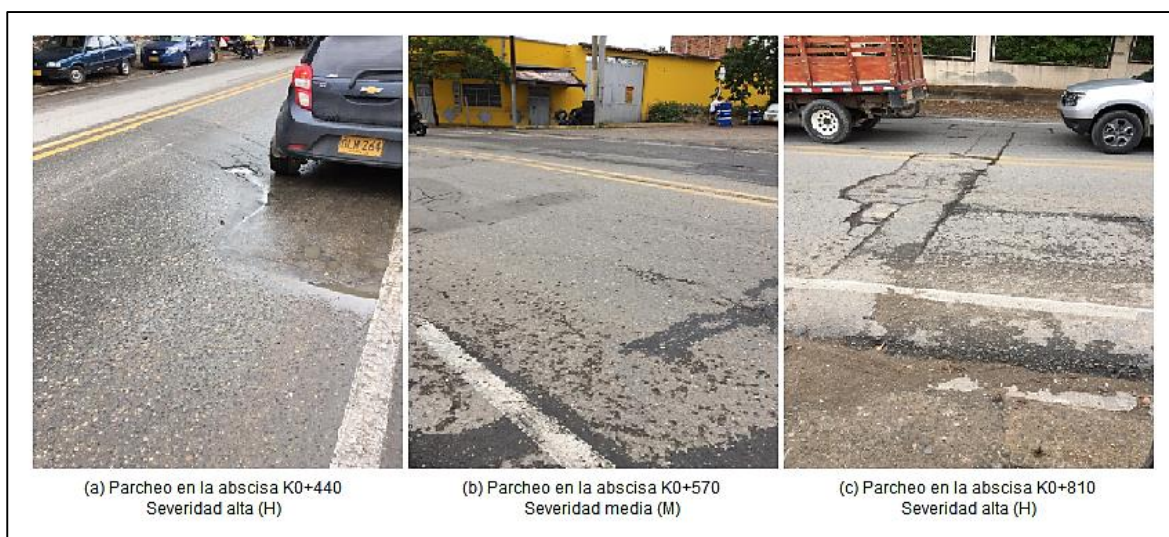
Ilustración 12. Parcheo en la vía (a), (b) y (c).
