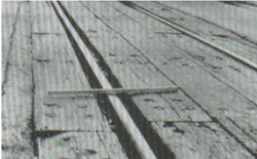
Figura 26. Cruce de vía férrea.
