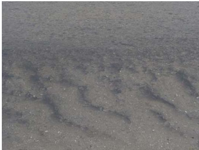
Figura 7. Exudación en el pavimento.
