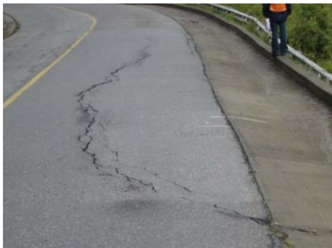
Figura 30. Grieta parabólica.
