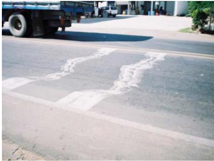
Figura 27. Ahuellamiento.
