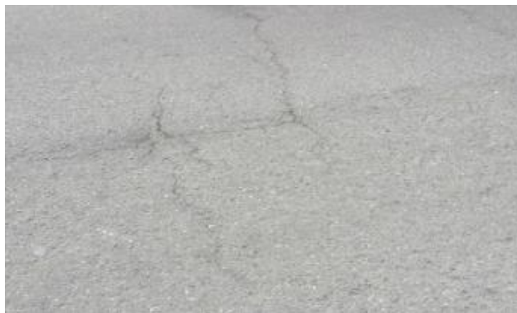
Figura 21. Grietas transversales.
