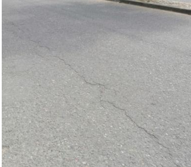
Figura 20. Grieta Longitudinal.
