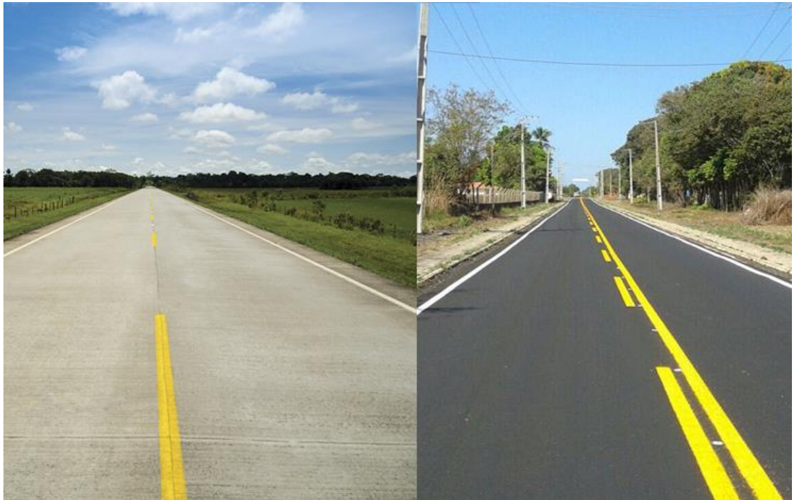
Figura 1. Pavimento Rígido y Pavimento Flexible.
