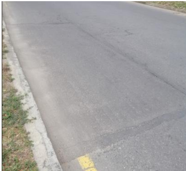
Figura 22. Parche de reparación en la vía.
