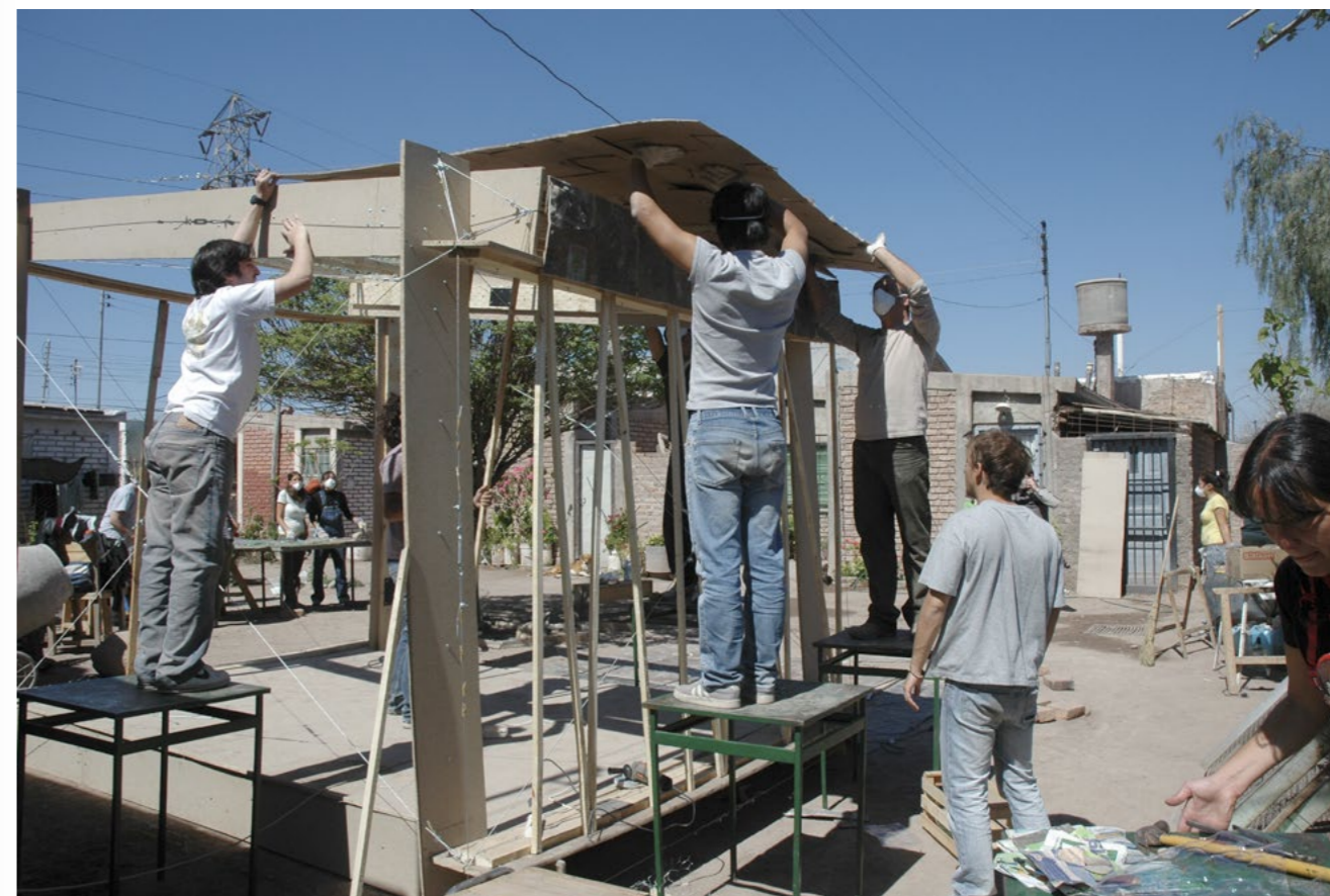
Modulo íntegro tensado (CC BY SA 4.0). Taller internacional de autoconstrucción sobre estructuras livianas. Figura 1
