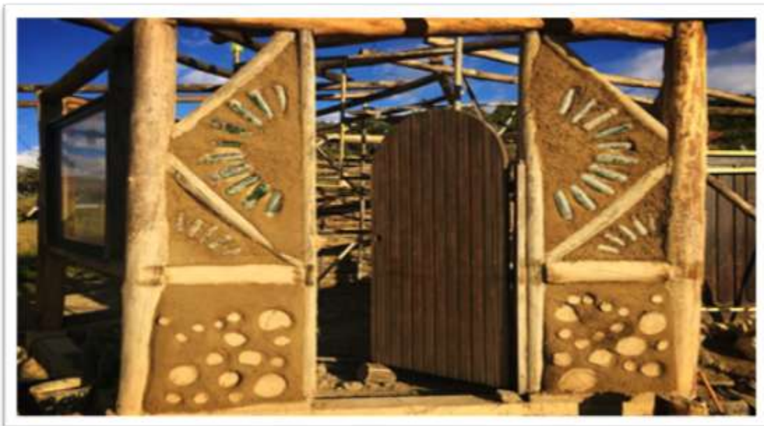
Fotografía 5 Cocina (Construida con barro; piedra; bahareque; paja y botellas para dar iluminación)
