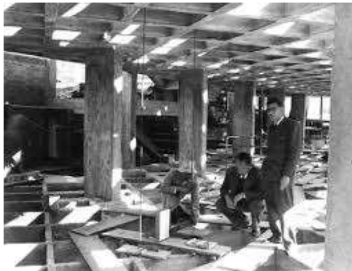
Figura 6, Estructura reticular celular edificio Nader. Fuente, http://dearq.uniandes.edu.co/sites/default/files/articles/attachments/DeArq_04_-_Vargas_Caicedo.pdf
