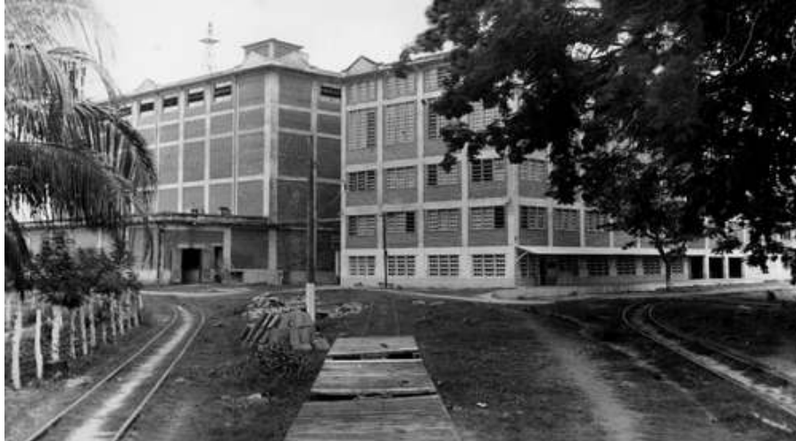
Figura 2. Edificio PACKING HOUSE
