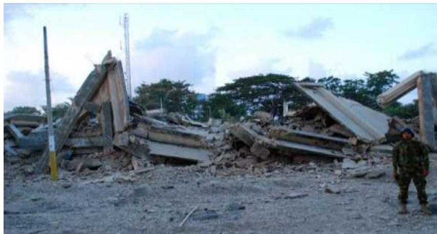
Figura 3. Implosión del edificio Packing House
