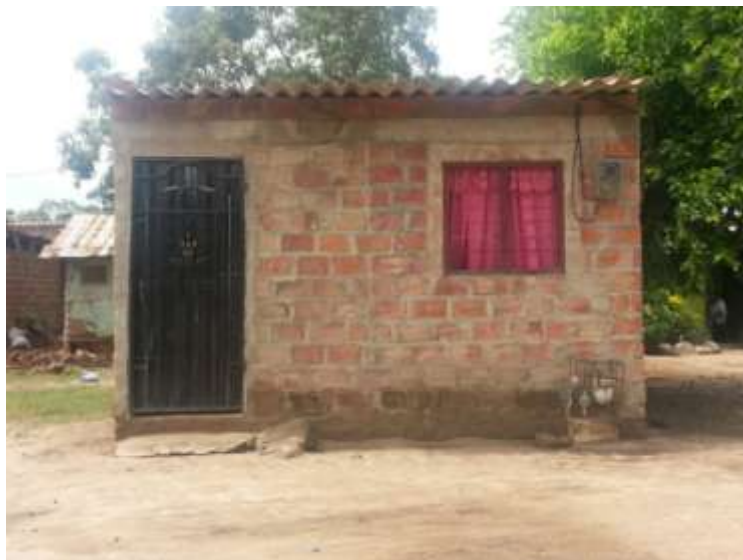
Figura 16. Foto de vivienda con paredes de ladrillos. Fuente propia.
